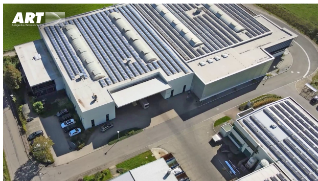
Abbildung 1: Luftbild der ART GmbH auf dem Campus der Knupfer Metallverarbeitung in Hohenstein-Eglingen (Quelle aller Abbildungen: ART GmbH).
